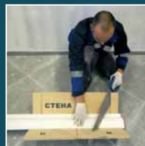
Монтаж лепного декора
