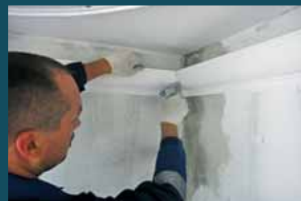
7. Место стыка зафиксируйте строительным степлером
